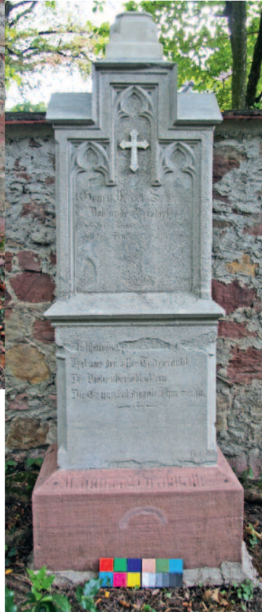
↓ Grabstein nach der Restaurierung
